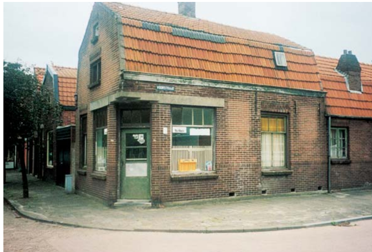
Figuur 1.42 Door brand kan grote schade ontstaan.
